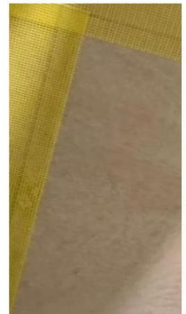
Optimal wird die Entkopplungsmatte auf dem Untergrund z.B. mit einem Reibebrett oder einer Gummirolle festverklebt/angedrückt. Die Mindestüberlappung beträgt ca. 3,0cm (siehe seitlicher Linienaufdruck). Die Entkopplungsmatte ist sofort nach der Verlegung begeh- und belastbar, auch für Transportwege.
