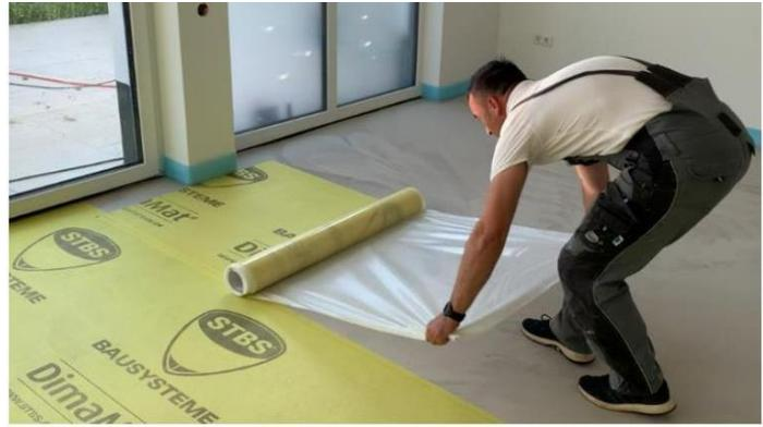
Einmal am Untergrund fixiert, kann dann danach die silikonisierte Abziehfolie unter der Matte abgezogen werden.
