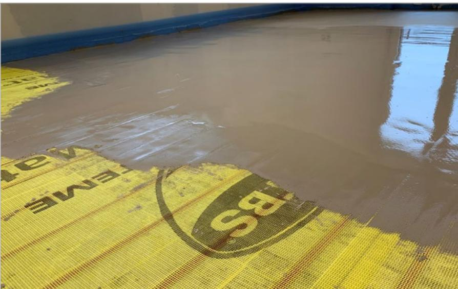
Einsatz bei dem dünn-schichtigem Fußbodenheizsystem SlimaTherm® TBS als Panzerentkopplung inkl. der oberseitigen Silikat Bodenspachtelmasse MortaColl® BAM 35-FS
