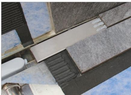
Abbildung hier WatoRin® SDR BT 00 „Belagsträger rahmenlos“
