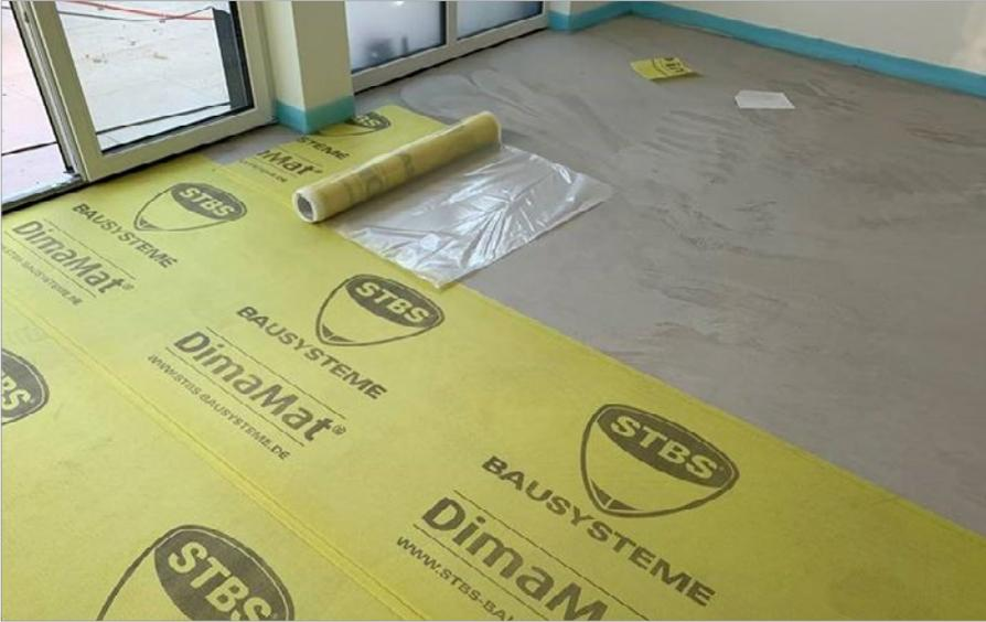
Einsatz bei dem dünn-schichtigem Fußbodenheizsystem SlimaTherm® NBS als Panzerentkopplung (ab 3 mm Überdeckungshöhe des Estrichs)
