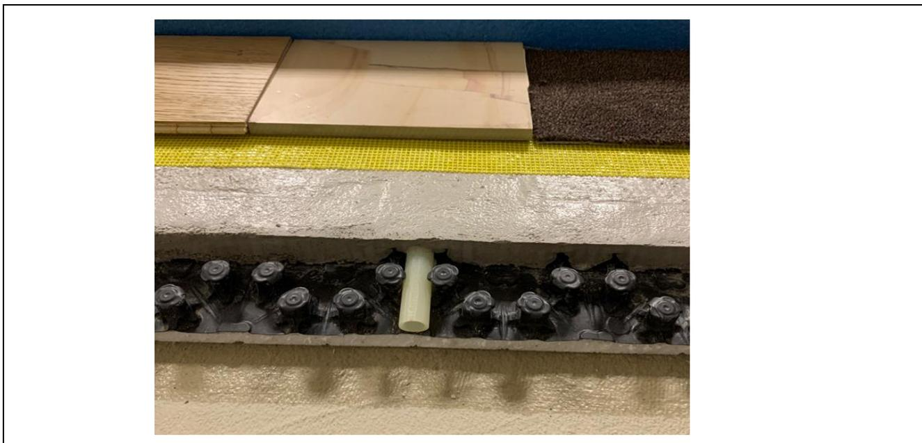
Im System sind alle Oberflächenbeläge über der Panzerenkopplungsmatte möglich, auch wenn diese angrenzend unterschiedlichen Höhen aufweisen. Ein Höhenausgleich bei dünnen Oberbelägen (z.B. Teppich oder Designbodenverlaufmassen) kann mit der faserarmierten, schwindfreien Silikatspachtelmasse STBS MortaColl BAM 35 ausgeführt werden. Als Estrich eignet sich ein Zement- oder Claziumsulfatestrich mit einer Mindestfestigkeit der F4 Klasse.
