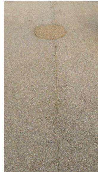
Oben links: Darunterliegende Wasserlinse. Unten links: Längsabriss durch Spannungen. Rechts: Schmutzfleckenbildung
